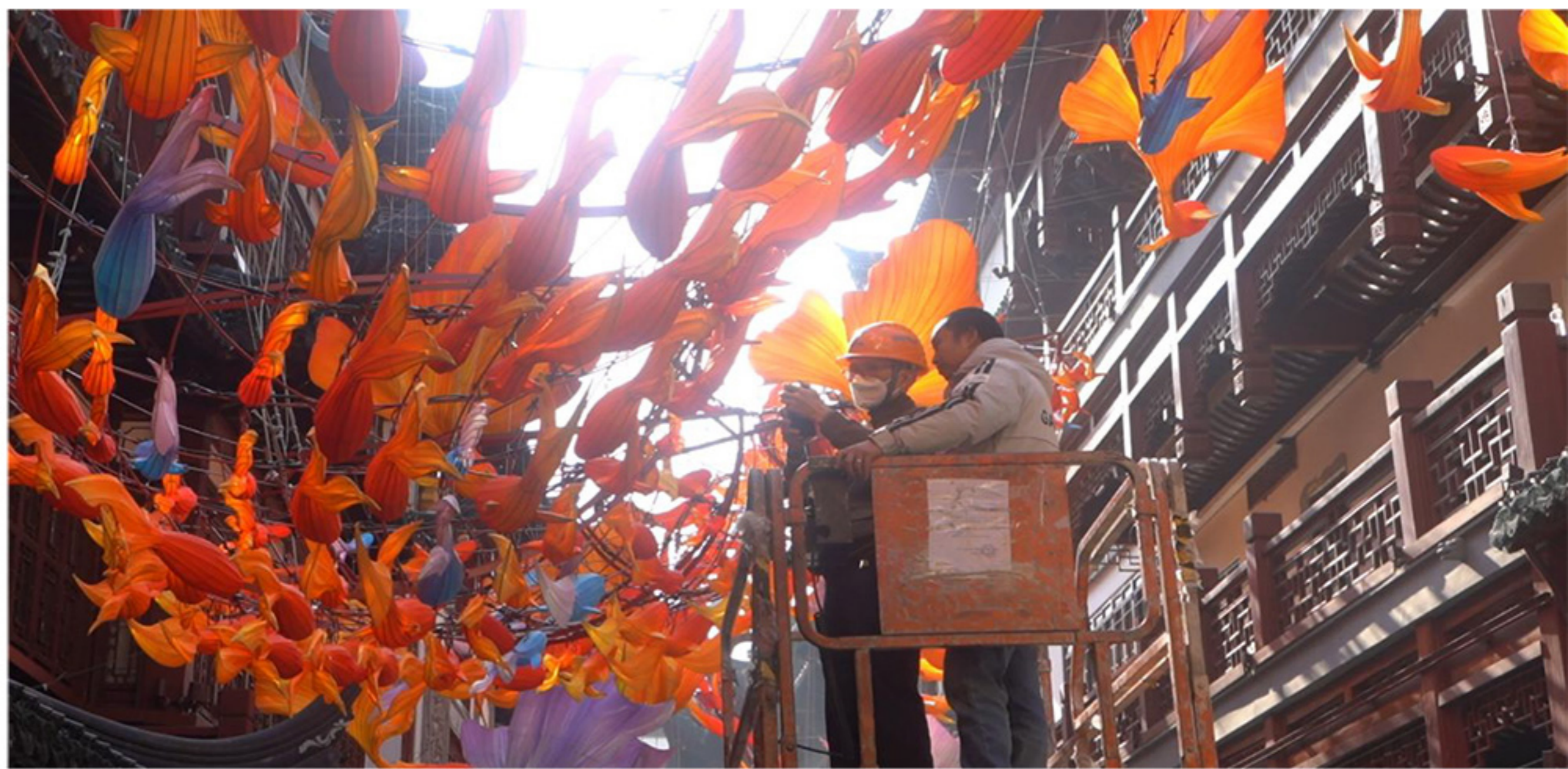
电气防火检测现场工作照片
